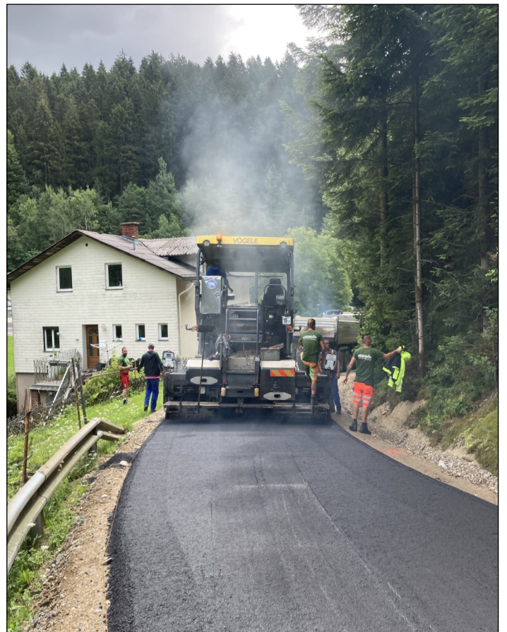
Asphaltierungsarbeiten der Firma Malaschofsky am GW Sattl
