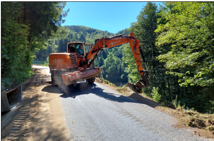
Bankettarbeiten durch Hubert Reuthner, um die Arbeiten am GW Sattl fertigzustellen
