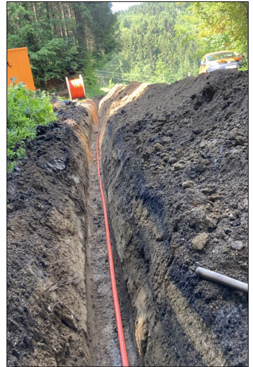
Leerverrohrung für ein zukünftiges Glasfaserkabel am GW Sattl
