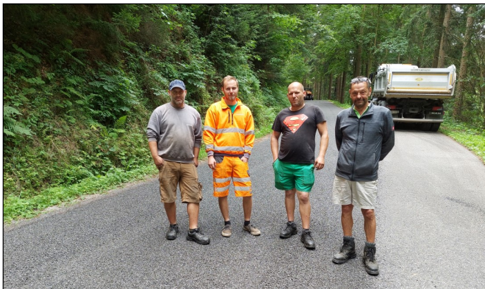
WEV Mitarbeiter Karl Brandstetter (r.) und das Team der Firma Kleinbruckner bei der Oberflächenbehandlung
