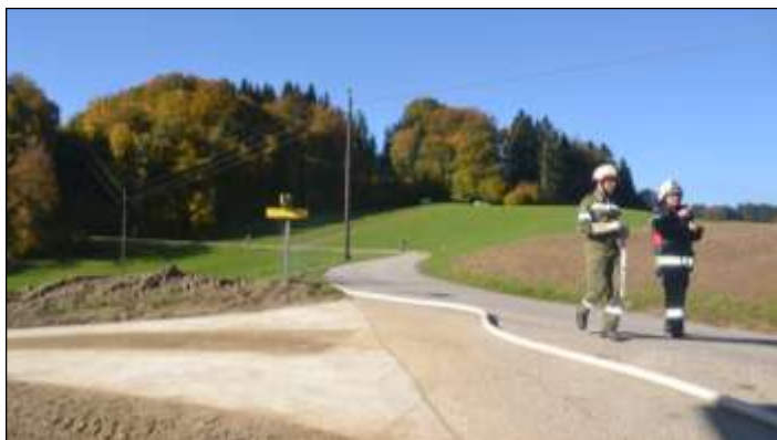
Johann Friesenecker und Gottfried Leonhartsberger kontrollieren die Schlauchleitung.
