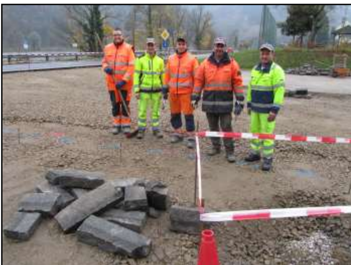
Das Foto zeigt v.l. Albert Leonhartsberger, Walter Aigner, Thomas Spiegl, Polier Franz Baumberger und Leopold Fasching auf der Baustelle.
