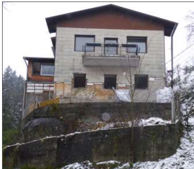
das Haus Steiner vor Beginn der maschinellen Abbrucharbeiten durch die Firma Hasenöhrl
