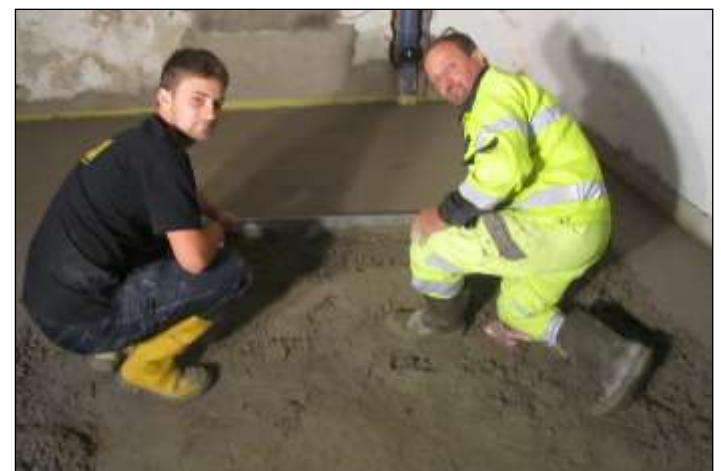
Pascal und Leopold Fasching beim Betonieren im Vereinsraum
