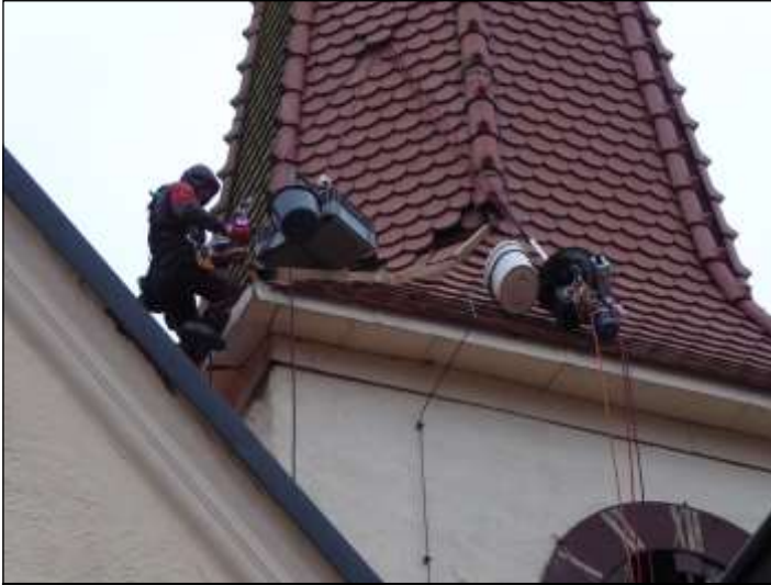
Mitarbeiter der Firma Ortner aus Lienz in Tirol haben in der zweiten Novemberwoche Ausbesserungsarbeiten am Dachstuhlholz des Kirchturmes vorgenommen.
