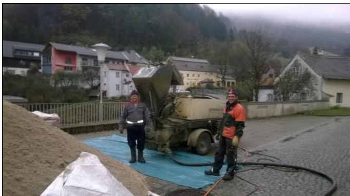
Martin Unterweger und Johann Fasching halfen u. a. beim Estrich mit.
