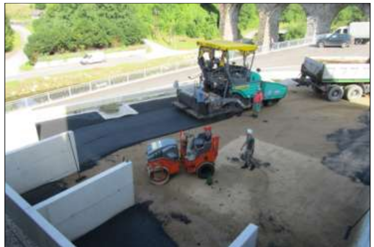
Ein Blick auf die Arbeiten im Bereich der Bauhofschütten.
