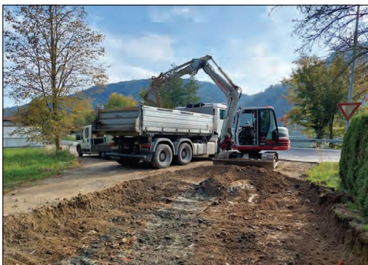
*Das Material des alten Unterbaus musste abtransportiert werden, bevor ein neuer Schotteraufbau erfolgen konnte.*
