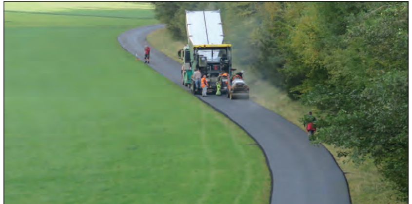
Rund 600 lfm Güterweg wurden von den Mitarbeitern der Firma Malaschofsky in Achleiten im letzten Monat neu asphaltiert, hier am Foto Asphaltierungsarbeiten Richtung Burner.
