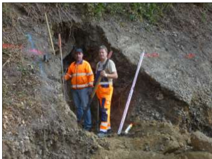
Polier Franz Baumberger (l.) mit seinem Kollegen bei Vorbereitungsarbeiten beim Pendlerparkplatz in Hirschenau
