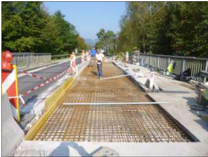
Das Foto zeigt die Mitarbeiter der Firma BT-Bau beim Eisenlegen bei der Brücke in Hirschenau.
