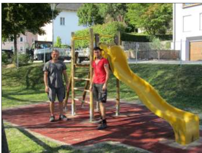
Mitarbeiter der Firma Stöttner haben den Kletterturm mit Fallschutz neu aufgestellt.
