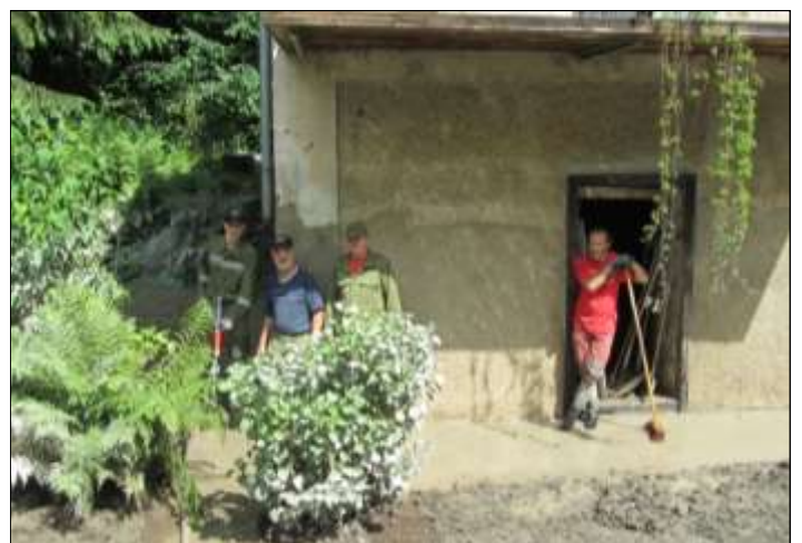
Aufräumarbeiten beim Haus Sarmingstein Nr. 15, ehemaliges Sigl-Haus.
