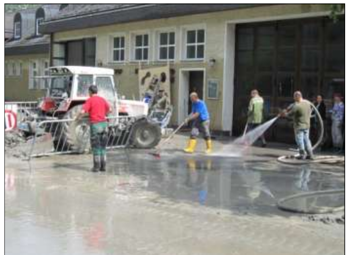
Aufräumarbeiten beim alten Gemeindezentrum
