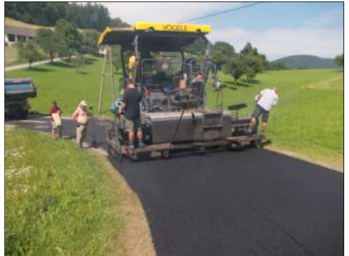
Bei glühender Hitze (mehr als 30 Grad) wurden die Asphaltierungsarbeiten durchgeführt
