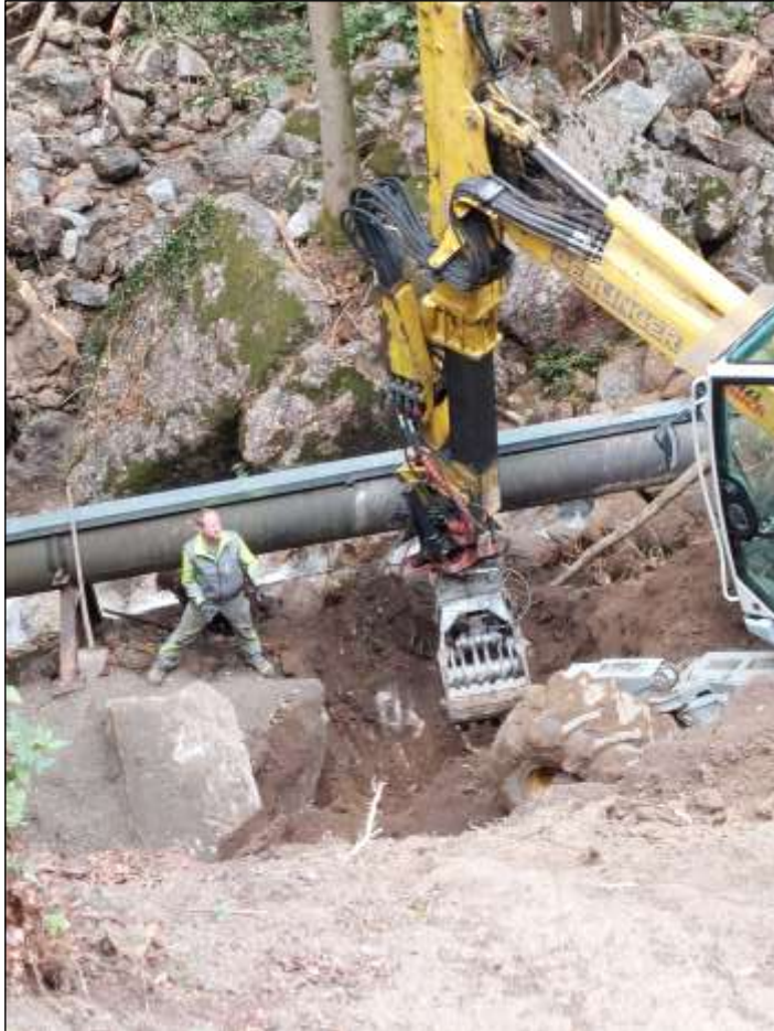
Direkt neben der Rohrleitungen wurde mit der Steinschichtung begonnen.
