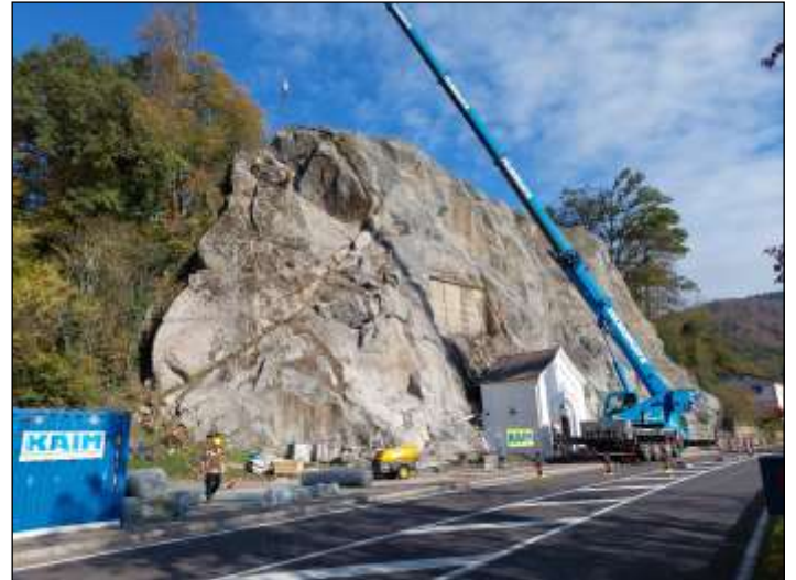
Fotos vom Montieren der Netze
