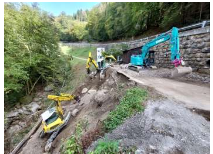
Thomas und Bernhard Gerlinger mit ihren Schreitbaggern sowie der Kettenbagger der Firma Petschl
