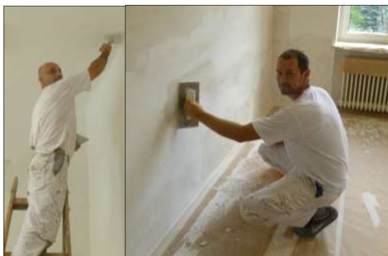
Die beiden Maler vor Ort bei Verspachtelungsarbeiten.
