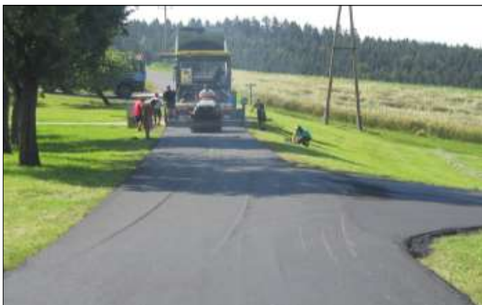
Asphaltierungsarbeiten der Firma Malaschofsky am GW Struden
