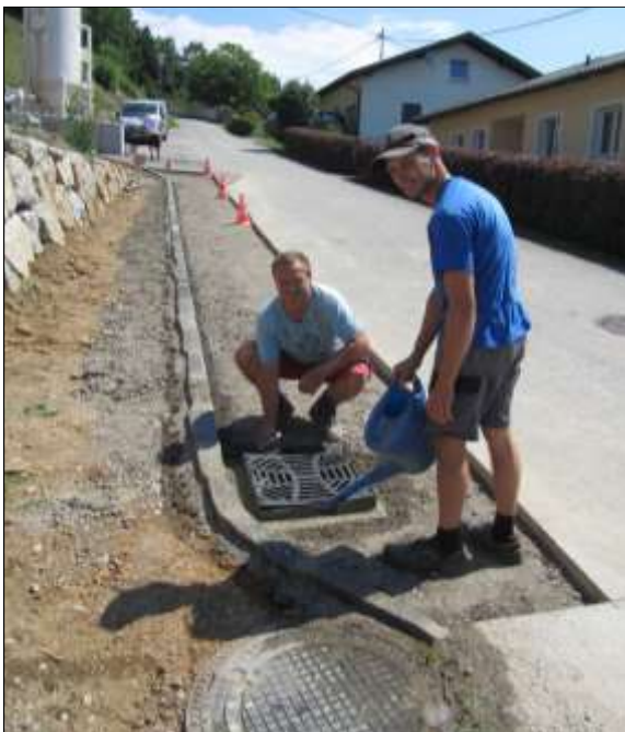
Leopold Fasching und Walter Aigner beim Ausfugen der gesetzten Leistensteine am GW Wörthbauer
