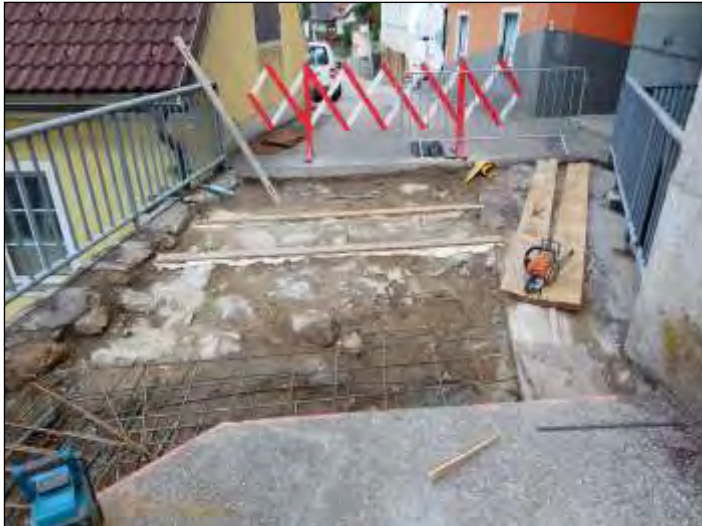
Das Foto zeigt Vorbereitungsarbeiten, bevor das erste Mal betoniert werden konnte.
