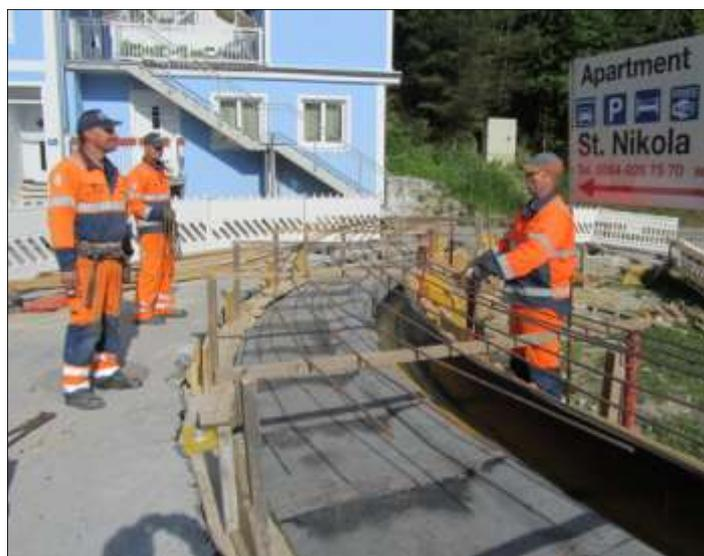
*Jede Menge Eisen musste fachgerecht für den Tragkörper verlegt werden.*
