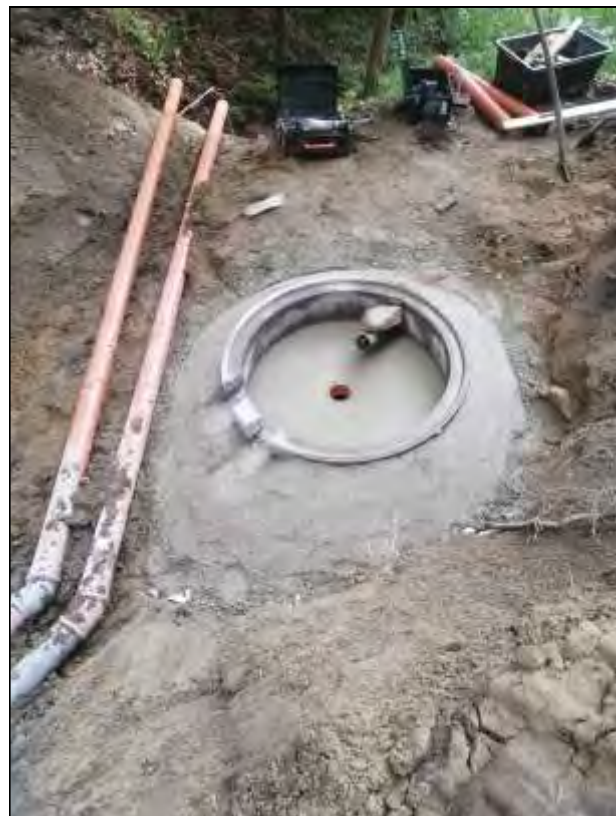
Blick auf den betonierten Boden eines Revisionsschachtes
