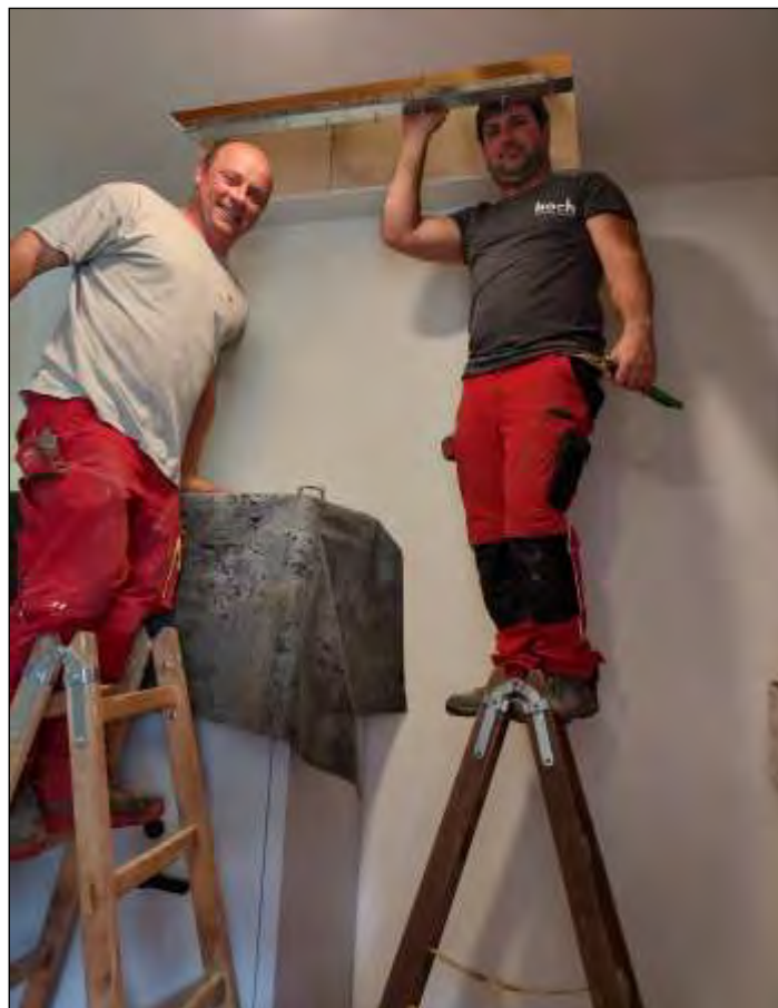
Erwin Leitner und Martin Lumesberger von der Firma Pöchhacker bei einer Deckenöffnung
