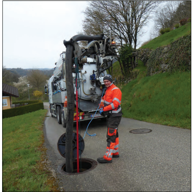
Im Vorfeld der Kamerabefahrung wurden die Schmutzwasserkanäle gespült und gereinigt.
