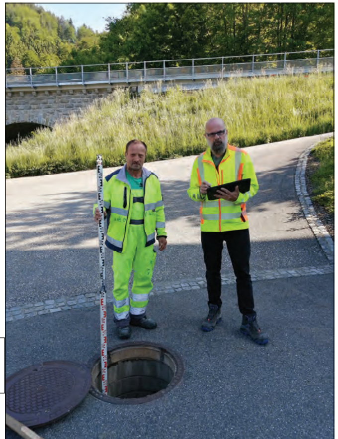
Leopold Fasching und Klaus Laimer beim Vermessen der Kanalschächte
