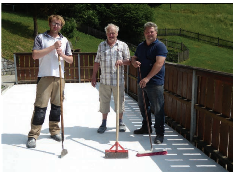
Das Foto zeigt Manfred Brandstetter (r.) mit Christoph und Konrad Schrödl bei den letzten Vorbereitungsarbeiten für die neue Terrassenabdeckung.
