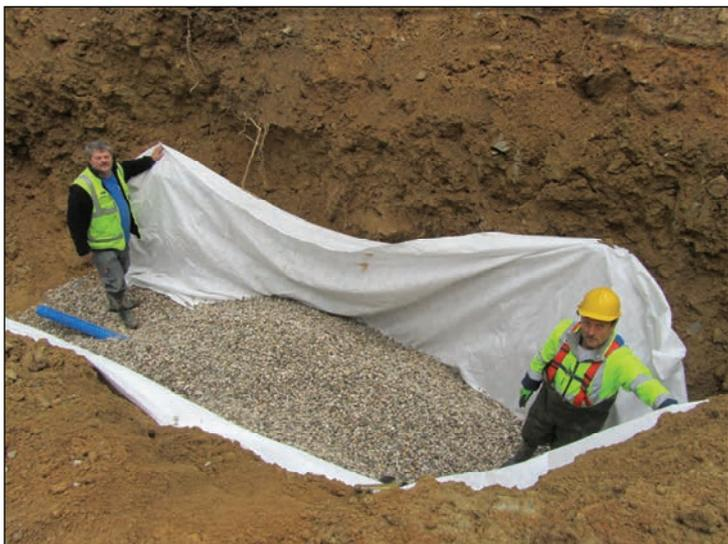
*Wasserwart Manfred Brandstetter und Leopold Fasching bei der Quelle I. Das gelochte Rohr im Bereich der Quellenfassung wird in gewaschenen Rollschotter gelegt, dieser mit einem Vlies eingefasst und darüber kommt noch eine dünne Betondecke, wie am rechten Foto zu sehen ist.*
