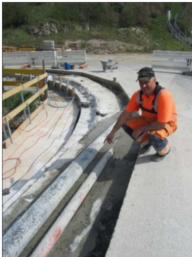
Polier Christian Leitner von der Brückenmeisterei erläutert die einzelnen Arbeitsschritte zur Brückensanierung und Gehsteigerrichtung.
