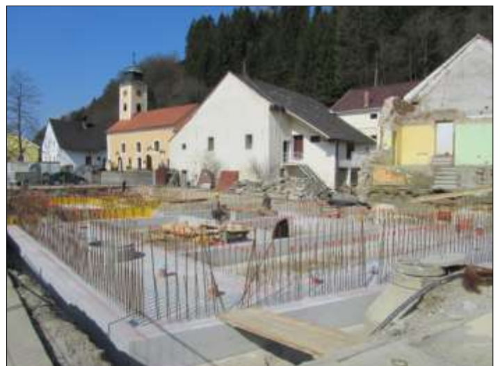
Blick auf die Baustelle Sarmingstein Nr. 2
