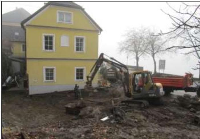
Ein Blick auf Vorbereitungsarbeiten für den Zubau beim Haus Sarmingstein 10 (Ettlinger)
