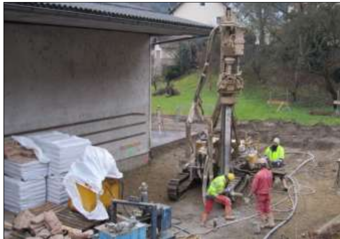
Vorbereitungsarbeiten für die Fundamentierung bei der Lagerhalle der Firma Seyr.
